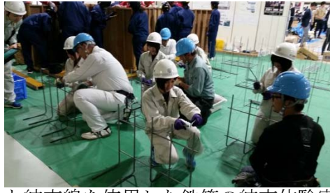
▲ハッカーと結束線を使用した鉄筋の結束体験実習の様子▼
