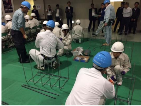
▲ハッカーと結束線を使用した鉄筋の結束体験実習の様子▼
