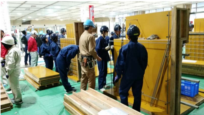
▲別の実習体験で組まれた型枠に対して鉄筋を組み付ける実習体験の様子
